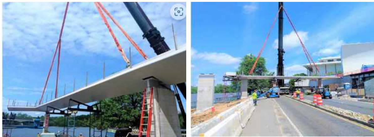
Hình 2. Cầu nâng lắp ráp cầu đi bộ thông qua các vấu treo (Nguồn: wmsi.com, 2021)
