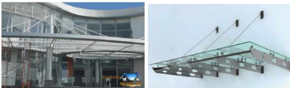
Hình 4. Kết cấu mái treo kính thông qua các vấu treo (Nguồn: xaydungso.vn, 2023)
